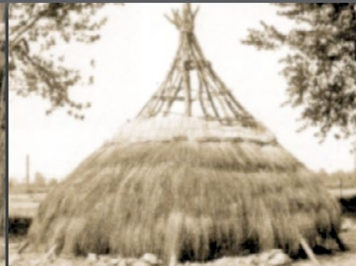
9/11 - Capanna ricoperta parzialmente con carice
