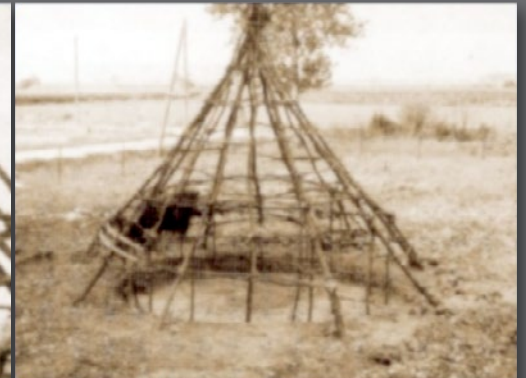
4/11 - La struttura portante quasi completa
