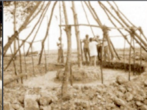
2/11 - Struttura principale portante appoggiata al palo centrale
