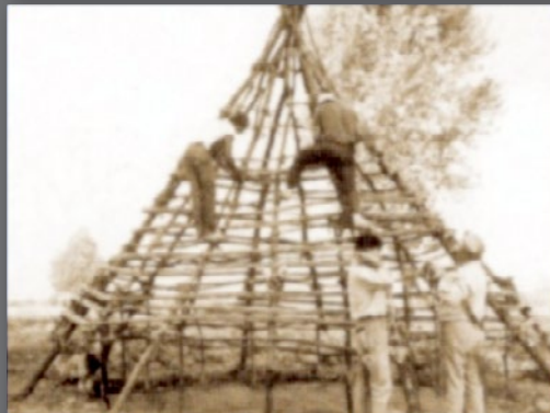
5/11 - La struttura del tetto viene completata con altri anelli
